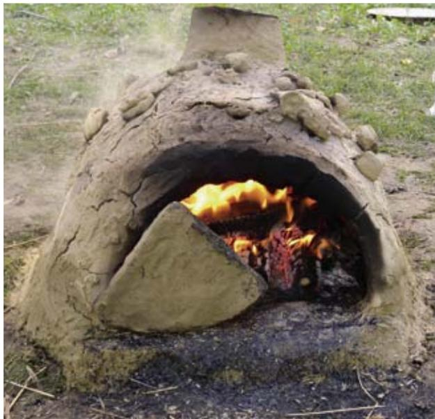
**Abb. 6: Der Lehmofen im Museumsgarten bei seinem ersten Einsatz. Da er noch im feuchten Zustand erhitzt wurde, bildeten sich Risse durch die Wände.**
