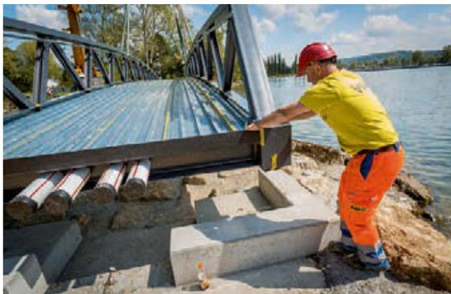
**Herzstück ist eine 25 Meter lange Stahlbrücke, die am Stück mit einem Kran gesetzt wurde.**
